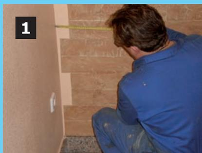
Medir la superficie a revestir para calcular el número de paneles necesarios. Comprobar la superficie de cada modelo de panel para adquirir las unidades necesarias.
