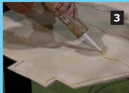
Una vez cortado el lateral aplicamos pegamento P-405 sobre la parte posterior del panel y pegamos directamente sobre la superficie a revestir e inmediatamente separamos para airear el pegamento y volvemos a pegar ejerciendo un poco de presión sobre el panel..
