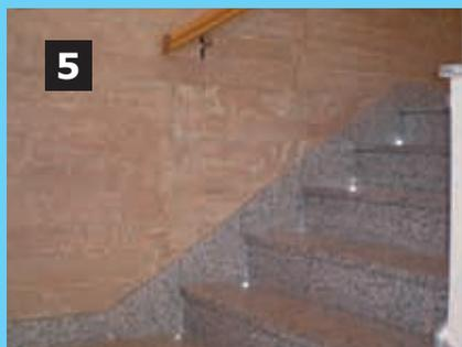
Una vez colocado el primer panel, repetimos la operación encajando los paneles enteros unos con otros hasta completar la pared.
