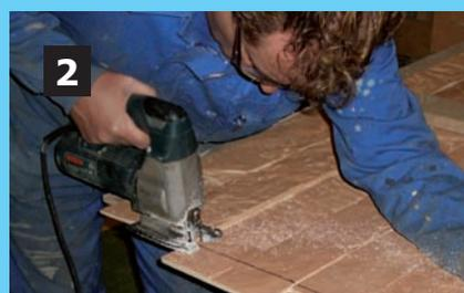
Para iniciar la instalación es necesario, en los paneles machihembrados, cortar la machihembra del lateral del panel para comenzar.
