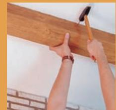
Trapanare il soffitti con una punta di 6mm per calcestruzzo, fissando il tassello di legno mediante la vite. Installare 3 tasselli per ogni trave. Tagliare la trave con l'aiuto di una sega secondo la misura richiesta. Accoppiare la trave ai tasselli del soffitti, fissandola con chiodi nelle parti laterali. Le possibili unioni fra le travi possono occultarsi con le fascette metalliche o applicando mastice nel giunto e posteriormente ritoccando con il colore riparatore.
