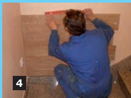
Es muy importante colocar la primera fila de paneles a nivel y en línea para que no queden juntas muy gruesas entre los siguientes paneles.
